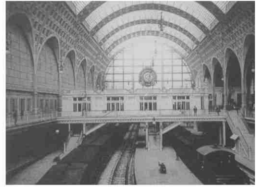
1 改造前奥赛火车站内景
