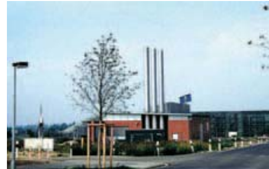
Stadtwerte Hannover AG energy centre
