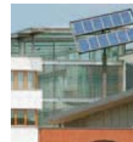
Stadtwerke Hannover AG photovoltaic installation
